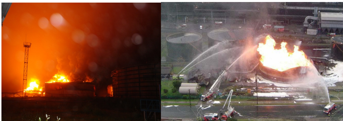
Рис. 1. Групповые пожары в резервуарных парках
