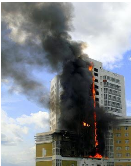
Рис. 4. Пожар фасада в многоэтажном жилом доме на ул. Ивана Бабушкина в Москве, 2009 г.
