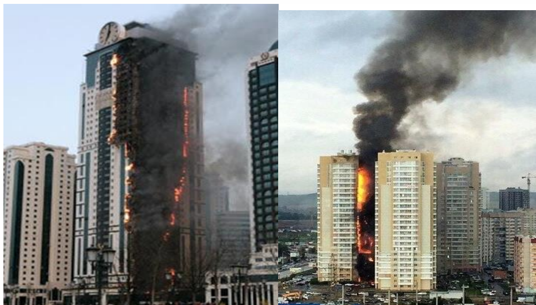
Рис. 5. Пожары в 25-этажном жилом доме в г. Красноярск 2014 г., в многоэтажном здании комплекса «Грозный-Сити» в г. Грозный 2013 г.
