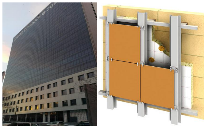
Рис. 2. НФС с воздушным зазором (офис продаж, г. Красноярск, 2016 г.)
